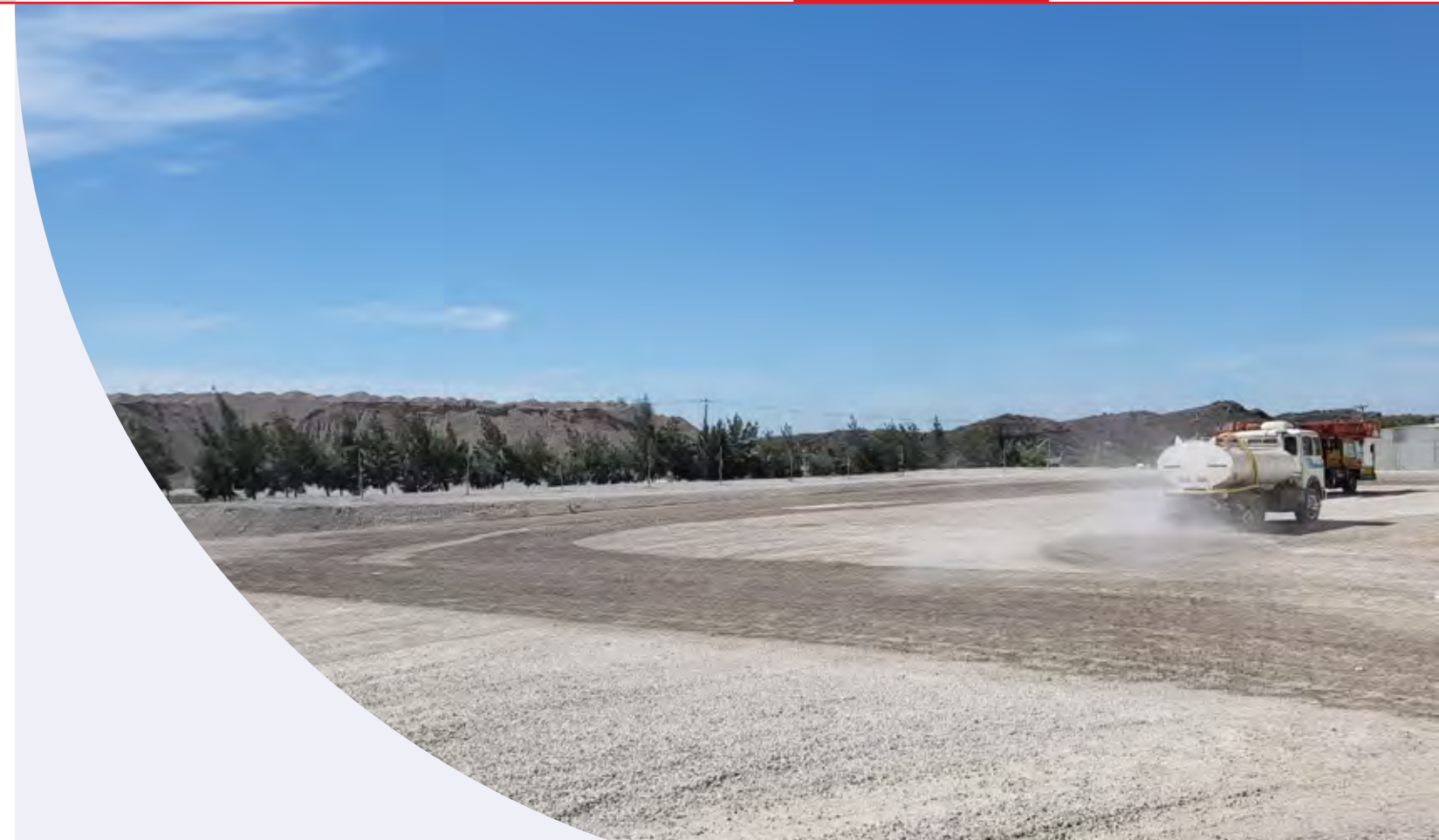
Riego de caminos con agua residual tratada, Planta Padre Bueno
