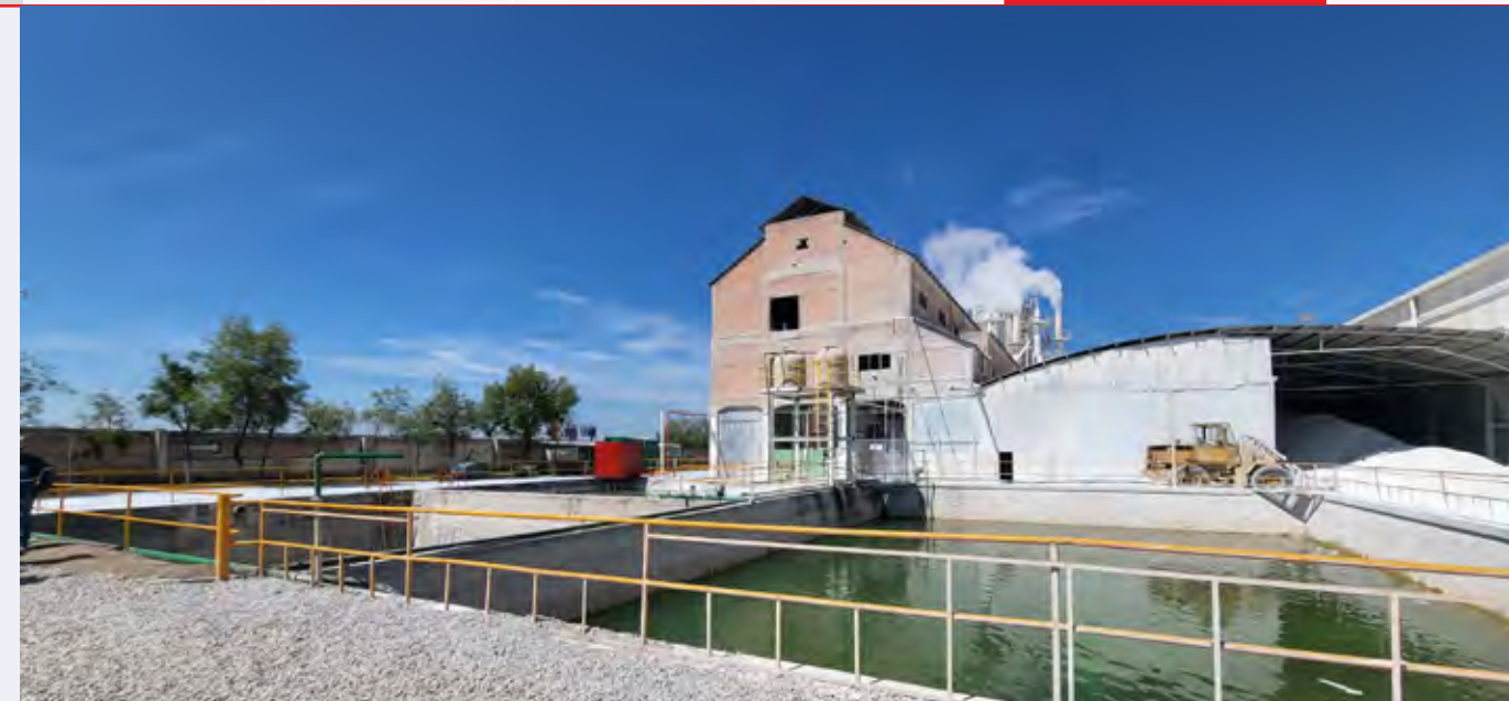
Piletas de almacenamiento de agua por captación pluvial de Planta Aguascalientes
