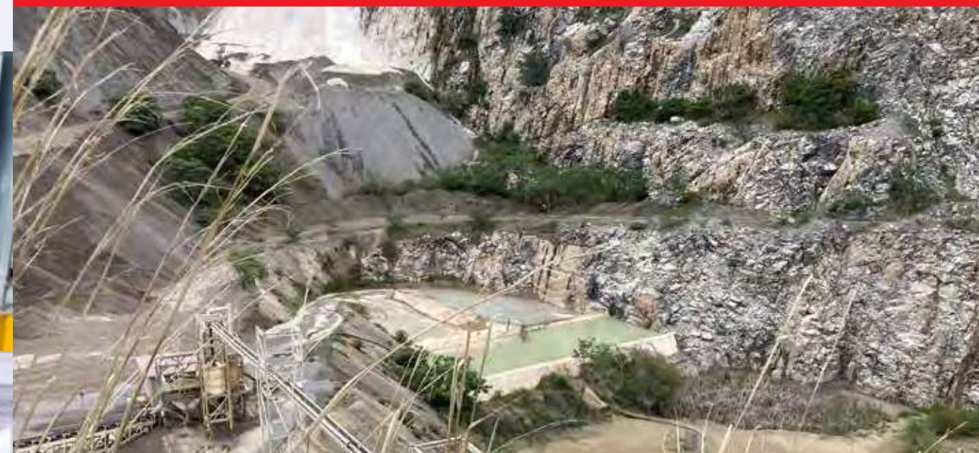
Piletas de almacenamiento de agua por captación pluvial de Planta Tecolotlán
