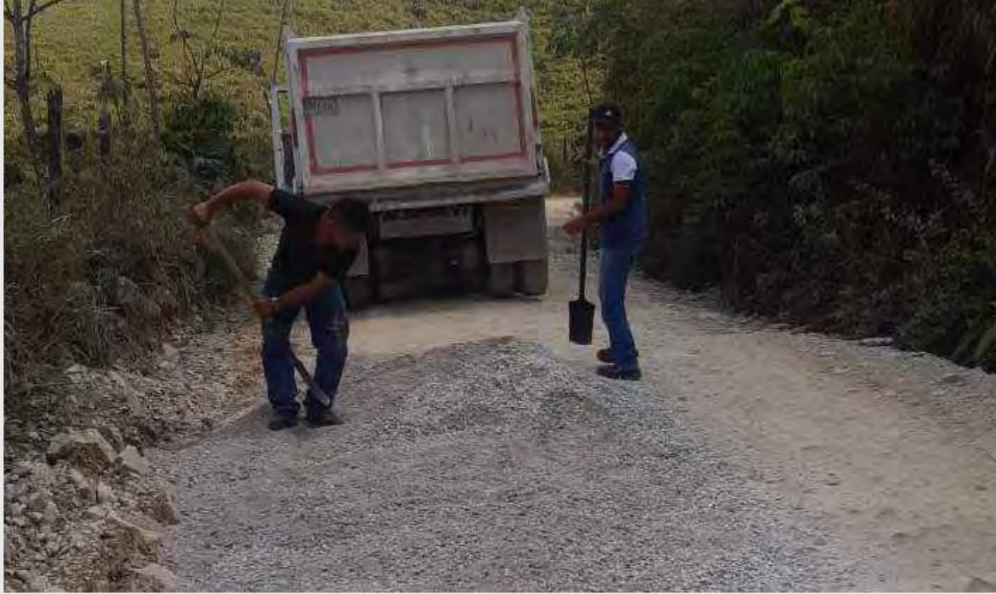
Actividad de rehabilitación camino a la Danta, Calidra Colombia.
