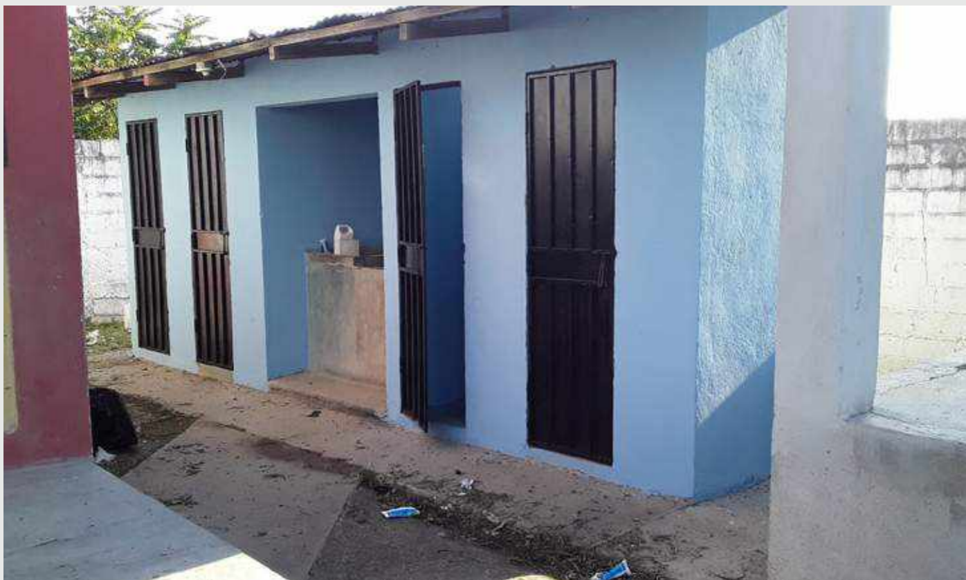
Remodelación de sanitarios en escuela Emilia Puerto. Planta INCAL, Honduras.
